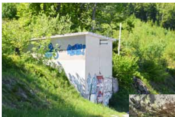
Poste électrique de l'Oeillon - Mai 2013
