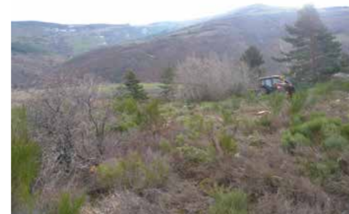
Travaux de restauration de la Lande du Sorbier (Châteauneuf).
